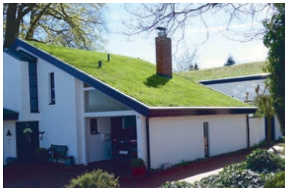
Zukunftsfähig: das ganze Dach ist begrünt.
